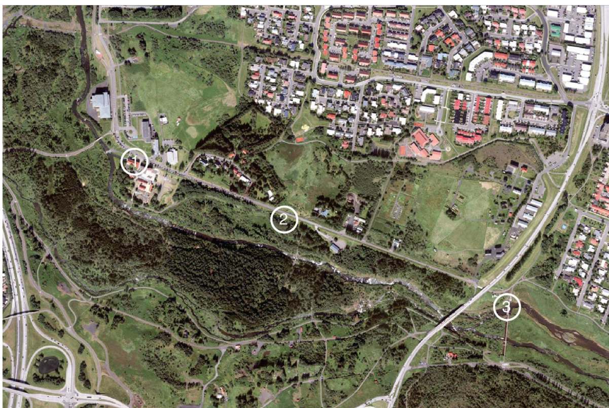
① Gama rafstöðin/Elliðaárstöð ② Aðfallspípan meðfram Rafstöðvarvegi ③ Árbæjarstífla
