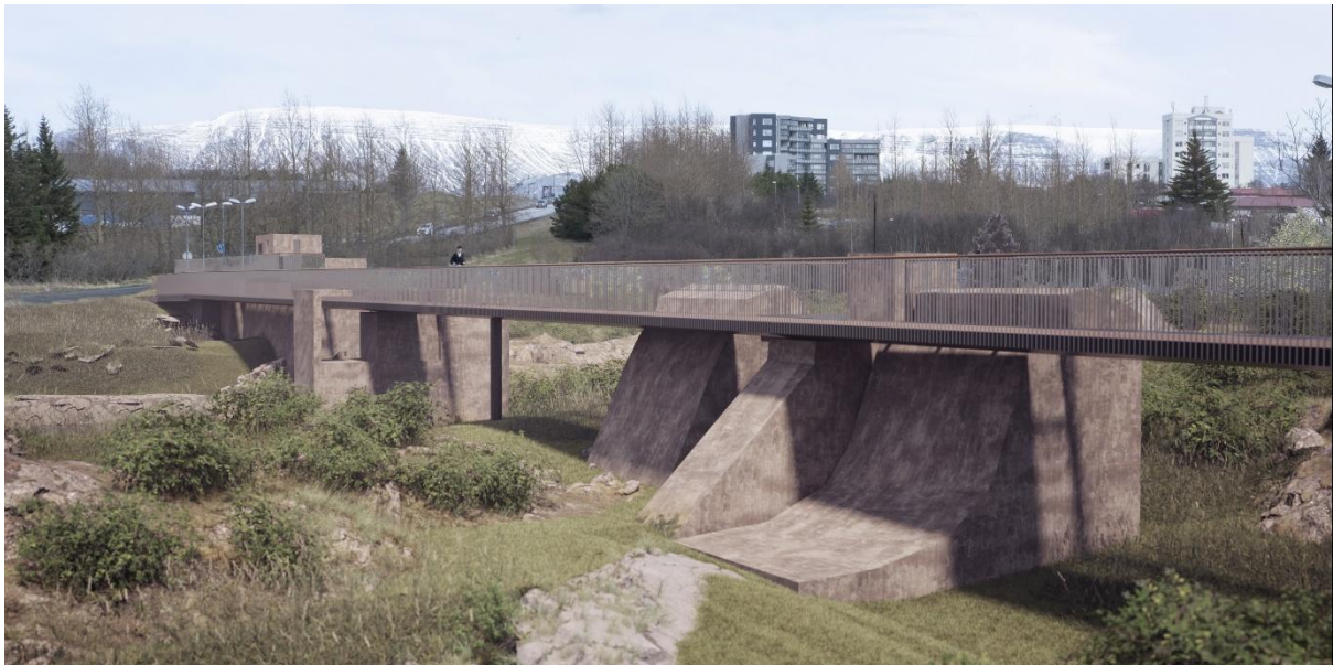
Mynd 3.6 Ásýnd upplifunarbrúar eftir breytingar á stíflumannvirki. Horft til norðurs í átt að Árbæ/Ártúnsholti (Terta, 2025).
