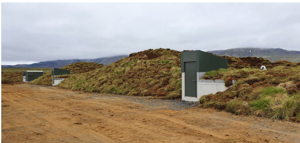
Gróðurtorfur af lóð Climeworks í Jarðhitagarði Orku náttúrunnar við Hellsheiðarvirkjun nýttar í frágang á vatnsvinnslusvæðinu í Engidal.
